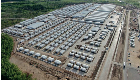
Amur Gaz İşletme Tesisi 17.250 Kişilik Yerleşim Kampı
